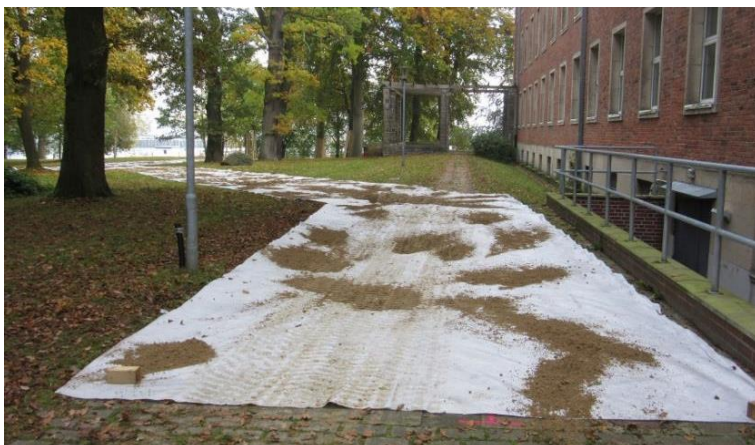
Vorbereitende Maßnahmen zu einer Baustraße durch einen Altbaumbestand
