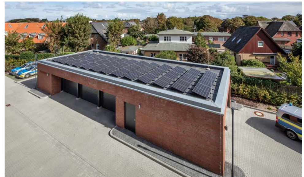
Abbildung 2: Polizeirevier Westerland auf Sylt, Photovoltaikanlage auf dem Fahrzeughallendach.
